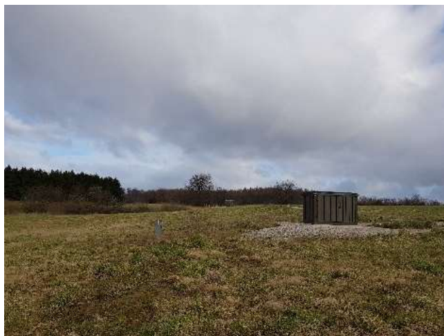
Figur 8 Flagsø Kildeplads, Furesø Vandforsyning
